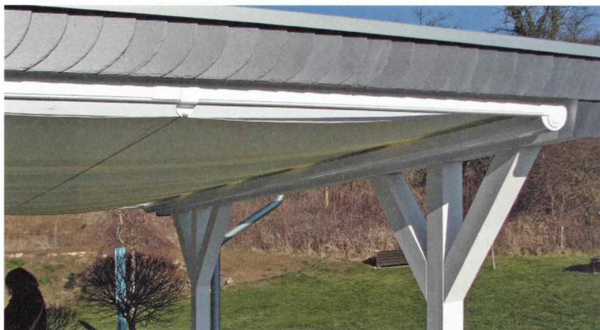
Der Besitzer einer verglasten Pergola bestellte als Beschattungselement eine Unterspannmarkise. Aufgrund der Platzverhältnisse sollte der Blendenkasten nach unten verlegt werden und die Anlage über eine geringfügige Steigung ausfahren. Fotos: Müller
