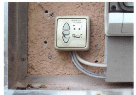
Der Elektriker hatte die Steuerung, auf Automatikbetrieb justiert, von außen unzugänglich und verdeckt in einem Schaltschrank an der gegenüberliegenden Wandseite im Dachbereich angebracht.
