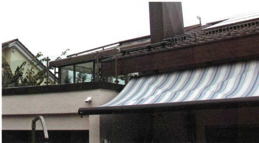
Infolge zu hoher Windlasten und der außer Kraft gesetzten Windwächterfunktion ist die Welle motorseitig links ausgebrochen, anschließend erfolgte die notdürftige Sicherung der Anlage.
