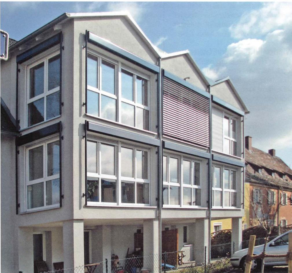
Nach erfolgter Montage der Raffstores beschwerte sich der Auftraggeber über den mangelnden Sichtschutz der Anlagen sowie über die vorhandenen Spaltmaße. Fotos: Müller
