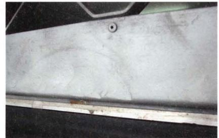
Der Montagebetrieb richtete die geringfügig verbogene Endleiste kalt und deckte die Spuren mit Kaltzinkfarbe ab.
